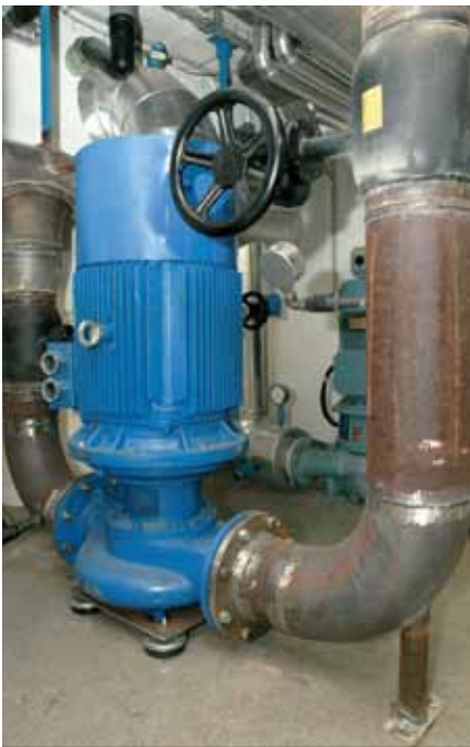
Trium-pumpen – af centrifugaltypen – trækkes af en frekvensomformerstyret Høyer-motor. Her er den under installering i varmeværkets fremløbsledning, kun elkablet mangler at blive monteret.
