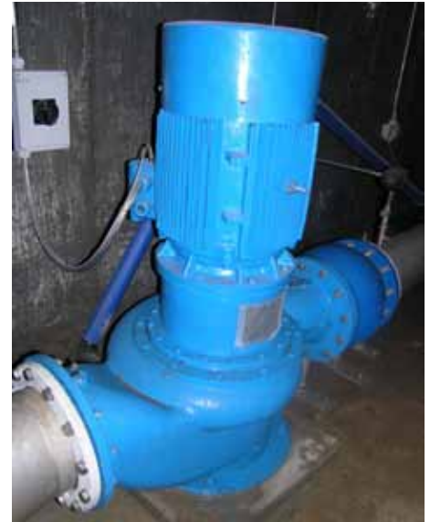
VLMT 300-300/450 HOLBÆK VANDVÆRK 900m 3 · 7mVS (6 polet motor)
